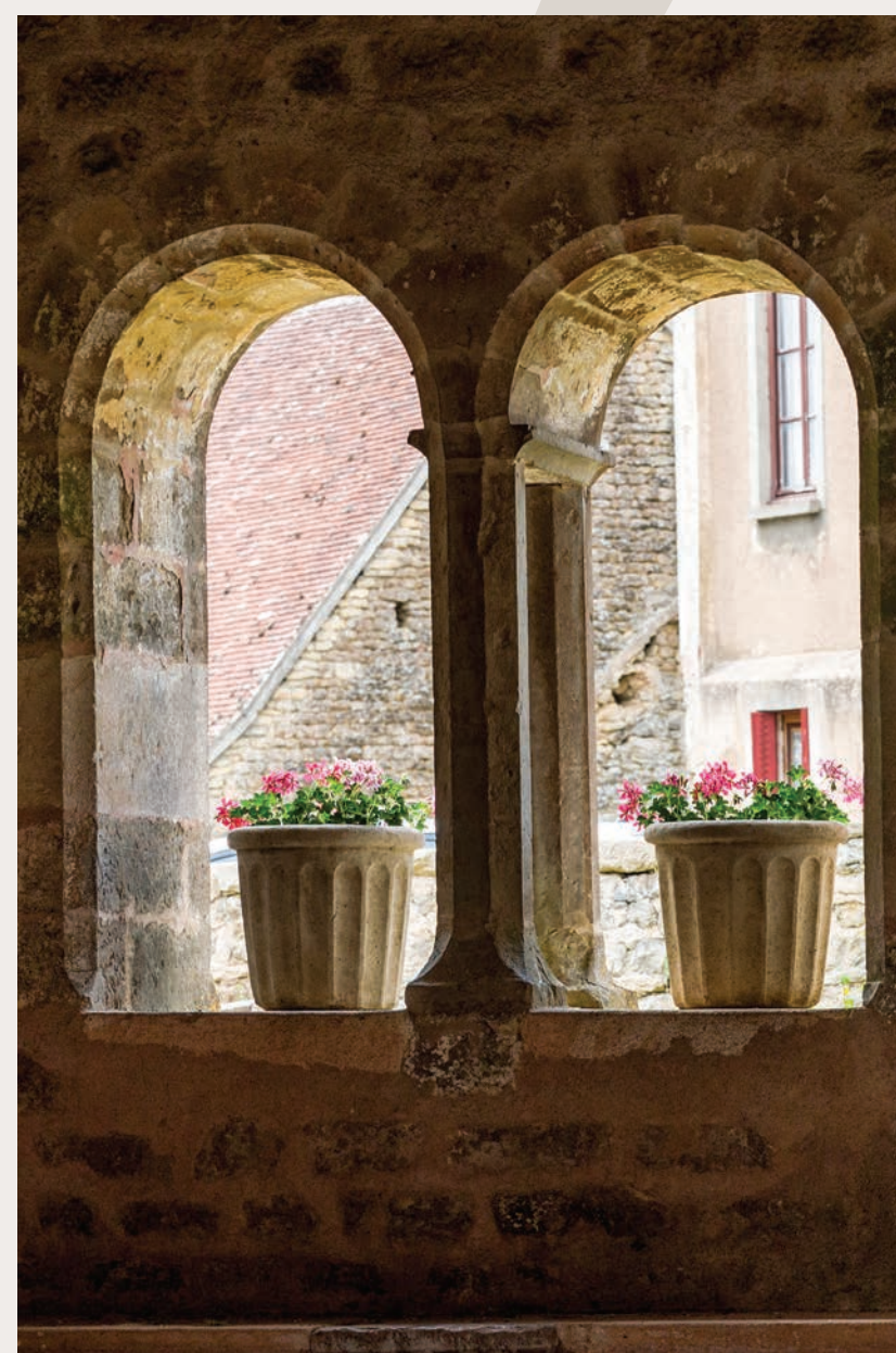
Baie géminée © G.Beurdeley
